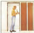
6. Дверь навешивают и выравнивают. Щель между коробкой и обшивкой стана заделывают герметиком (монтажной пеной).
