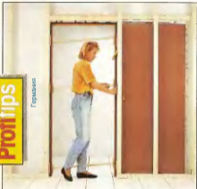
1. После обшивки каркаса перегородки, одну его сторону обшивают и устанавливают верхний направляющий рельс.
