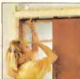
8. Створки устанавливают таким образом, чтобы при закрывании дверь не доходила до нескольких миллиметров до дверной коробки.
